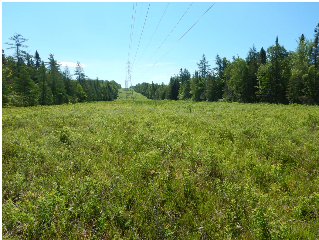
Photo 1. Ligne de transport d'électricité existante qui traverse le parc national
