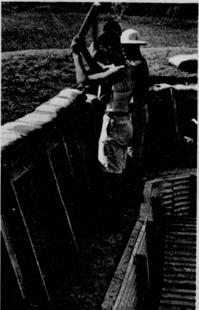
Les officiers qui suivent les cours de qualification au centre d'entraînement à Brockville font eux-mêmes les exercices qu'exécutent les soldats. Voici un exercice de construction d'une tranchée
