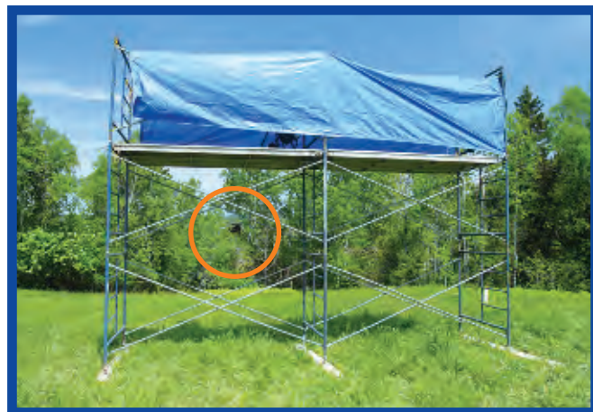
Le terrain étant légèrement en pente, trois échafauds de 1,5 mètre de haut ont été installés sur des pattes ajustables, afin d'être sécuritaires. La plateforme de prise de vue se trouvait au deuxième niveau, alors que le troisième étage supportait la toile.
