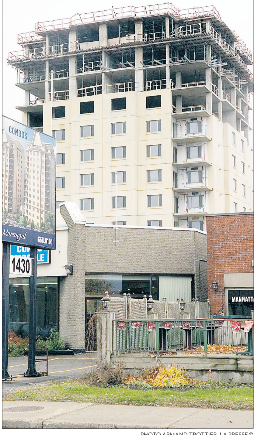
Les travaux de la première tour du Martingal, boulevard St-Martin, à Laval, ont été interrompus l'hiver dernier.
