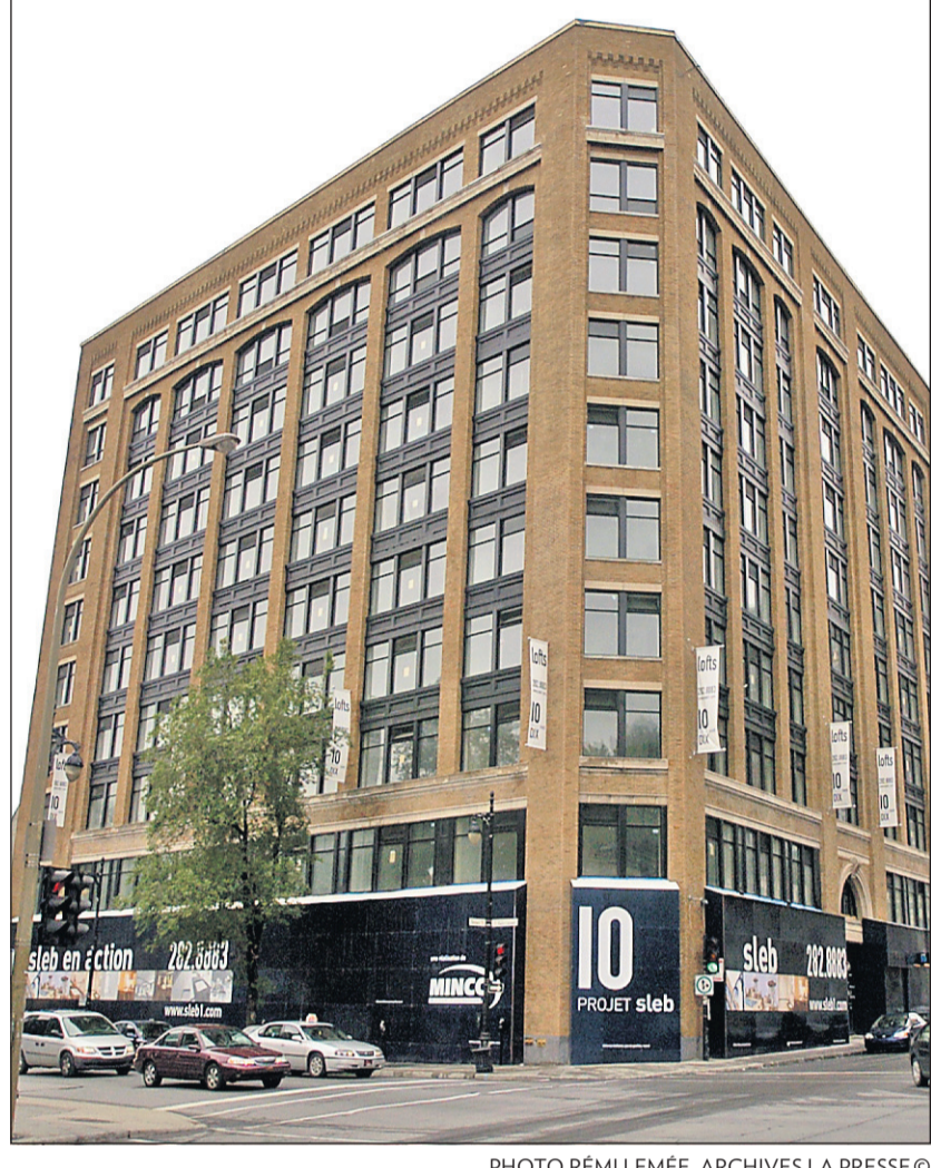
Le SLEB, boulevard St-Laurent au sud de Sherbrooke, il y a un an. La construction est arrêtée depuis des mois.
