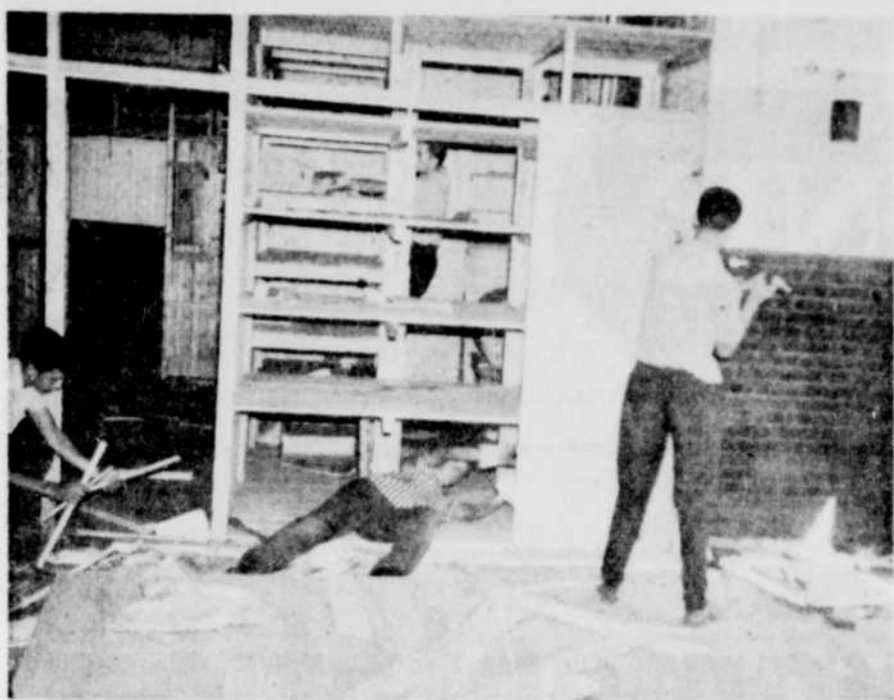
ON A COMMENCÉ À DEMOLIR L'INTÉRIEUR. — Quelques employés ont commencé hier matin à démolir l'intérieur de l'usine Fashion Craft, sur la rue St-Jean-Baptiste, à Victoriaville. On sait que les nouveaux propriétaires désirent transformer cette construction en un hôpital pour malades chroniques et convalescents. Le projet est présentement devant le ministère de la Santé à Québec; on y demande un permis d'opération d'une institution de 200 lits, ce qui donnerait du travail pour quelque 150 personnes.
