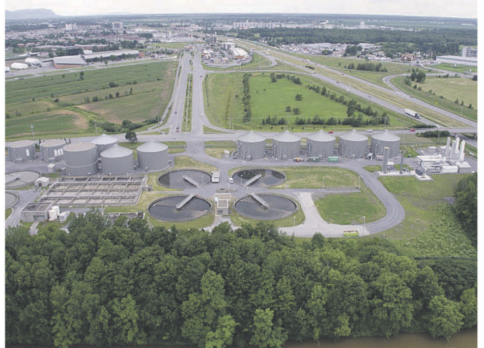
Le bris constaté la semaine dernière à l'usine d'épuration de la Ville de Saint-Hyacinthe est survenu alors qu'un vaste projet de mise aux normes et d'augmentation de la capacité doit être mis en œuvre prochainement au coût de 33,8 M$. Photothèque | Le Courrier ©
