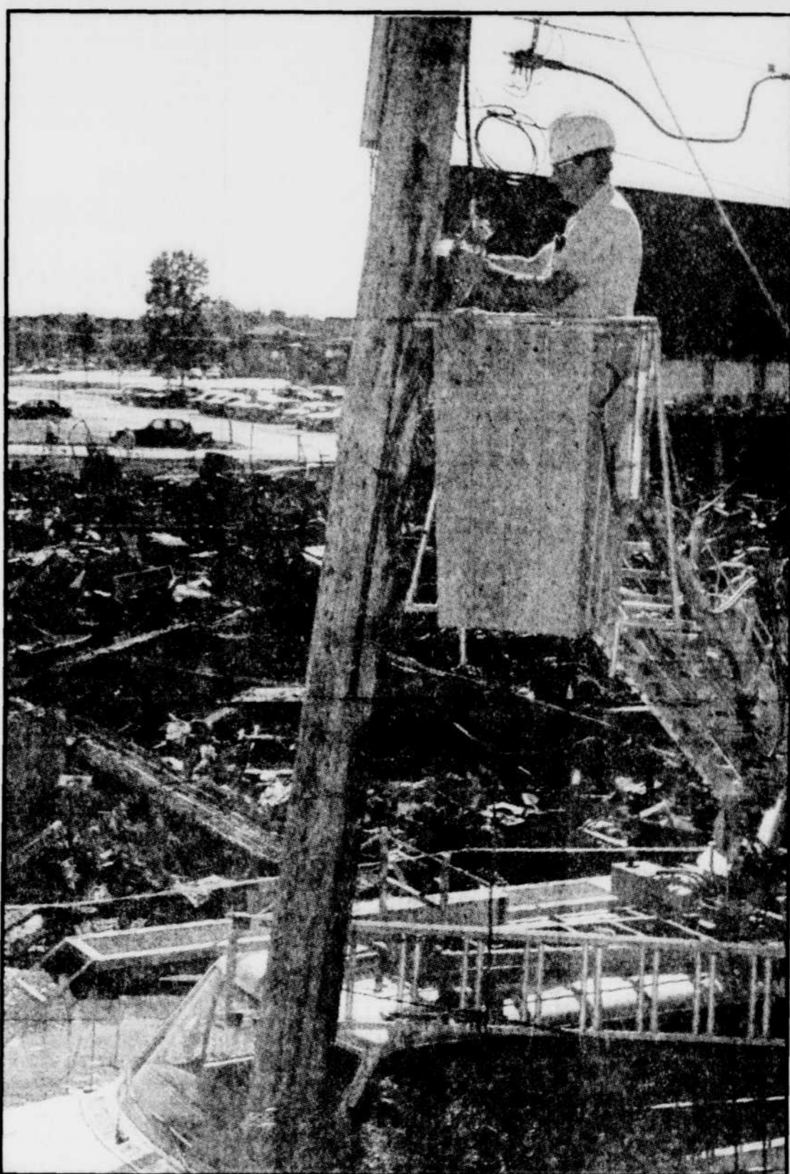
Les équipes de techniciens de Bell Canada se sont affairées durant toute la fin de semaine afin de rétablir le service téléphonique coupé à la suite du sinistre.
