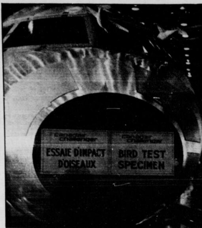
Voici le premier avion-maquette devant être soumis aux essais d'impact d'oiseaux, pour éprouver la résistance de la cabine de pilotage.
