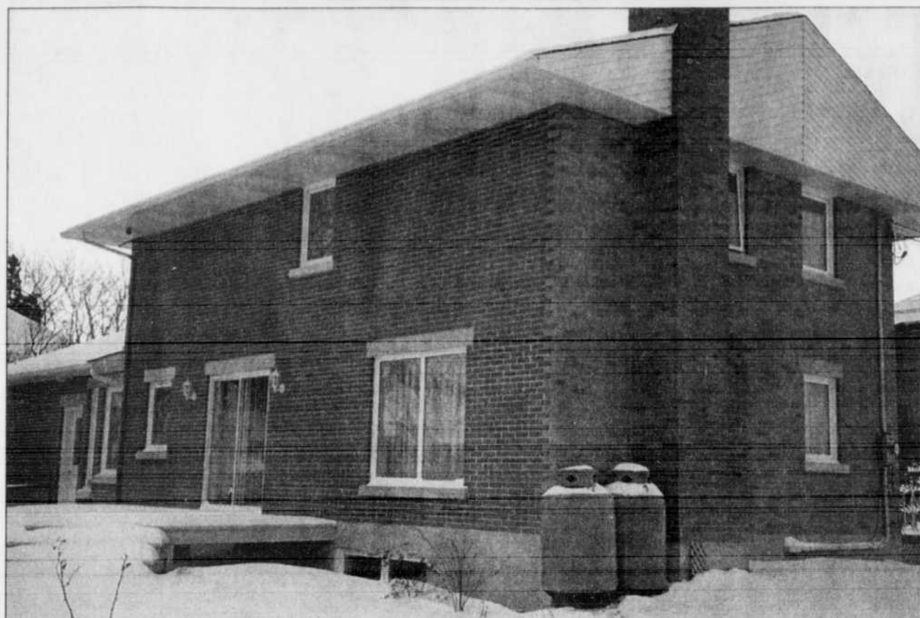
On aperçoit, à l'arrière du 47, rue Saint-Louis, les bombonnes de gaz propane alimentant le système de chauffage.
