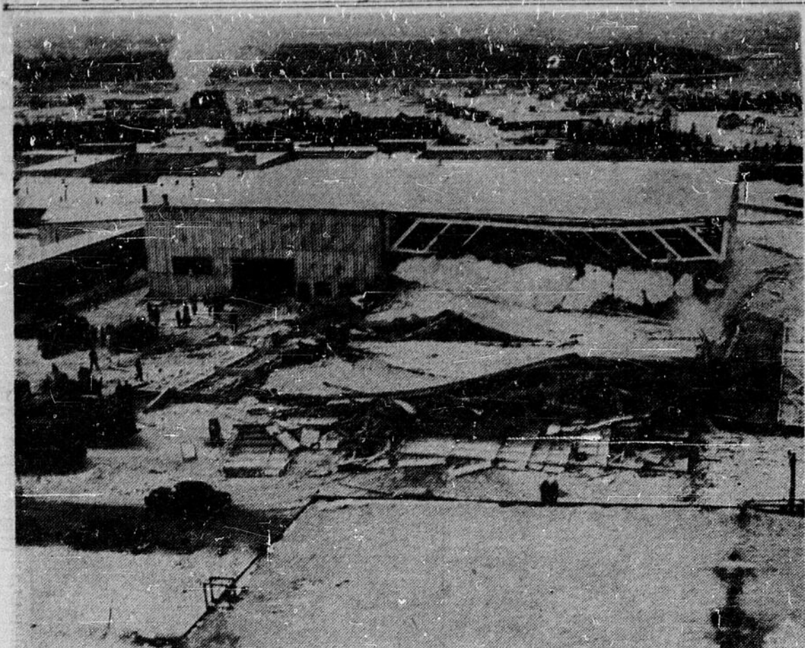
UN GARAGE-EXPOSITION S'EFFONDRE — Avant son effondrement mystérieux ces jours derniers, ce nouveau garage qui servait de salle d'exposition pour le transport motorisé, à la base navale de Sherewater, de l'autre côté du
