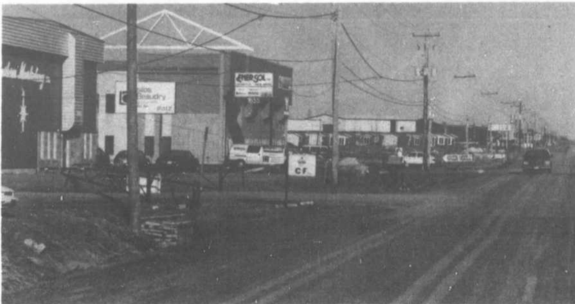
L'ensemble des travaux d'infrastructures sur le boulevard de l'Industrie nécessite des dépenses de 1,7 million de dollars.
