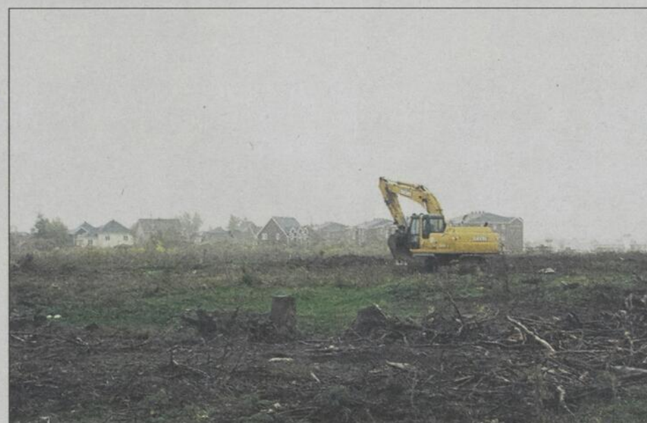
Comme en témoigne cette photo prise la semaine dernière, les travaux de construction du nouveau magasin d'alimentation couvrant une superficie de 46 000 pieds carrés devraient débuter sous peu.
