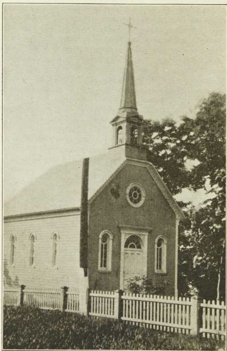
CHAPELLE SAINTE ANNE, construite en 1905.
