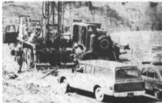
L'usine est située à proximité d'une lagune contaminée que la Goodfellow s'est engagée à vider pour remplir ensuite de terre au compte du ministère de l'environnement. Sur la photo, des employés du gouvernement prennent des échantillons du sol, à 90 pieds de profondeur, afin d'évaluer l'efficacité du traitement.
