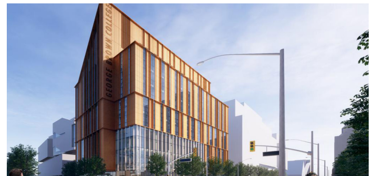
(Collège George Brown) : Les travaux de construction de la place Limberlost devraient être terminés d'ici la fin de l'année, où le premier édifice carboneutre en bois massif a été érigé. Crédits: Collège George Brown
