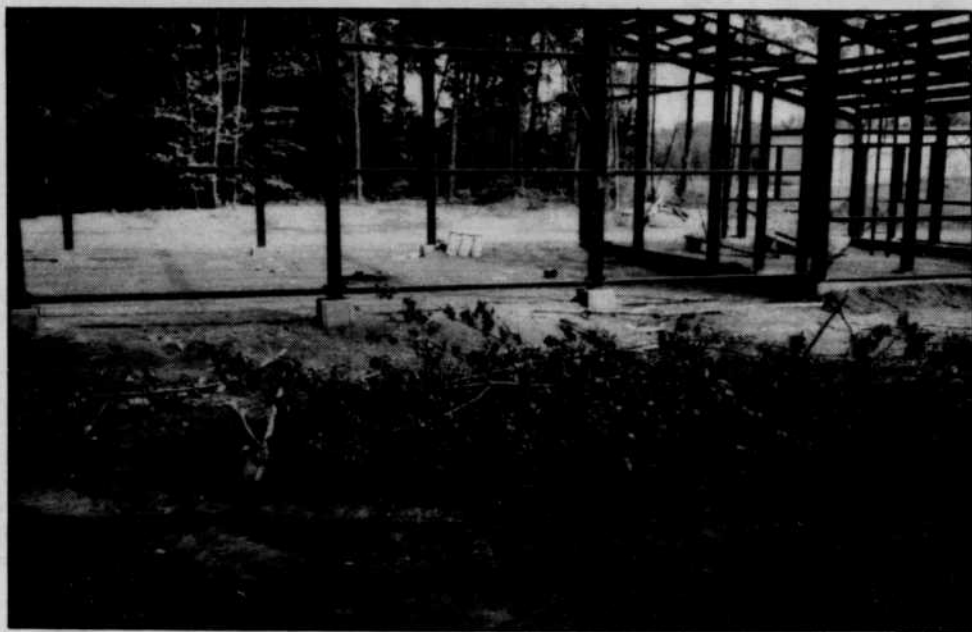
La structure métallique de l'usine de compostage Valoraction s'élève déjà sur le terrain adjacent à l'usine d'épuration des eaux de Cowansville.
