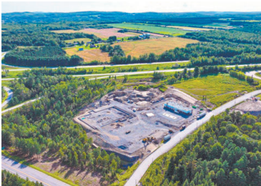
Les travaux vont bon train dans le Quartier du Moulin. Entre autres, un restaurant McDonald's y sera aménagé.
