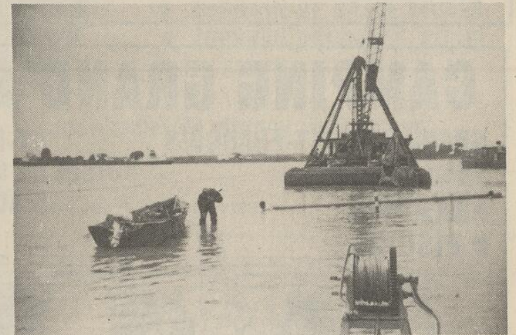
1966: CONTRECOEUR - MISE EN PLACE D'UNE CONDUITE D'ENTRÉE D'EAU.
