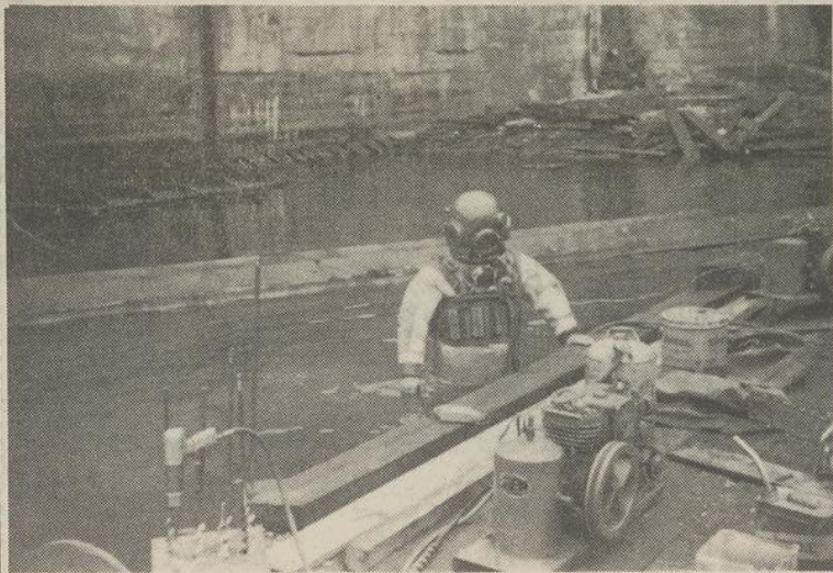
1965: PONT JACQUES-CARTIER - INSPECTION - RÉPARATION DE QUAIS.
