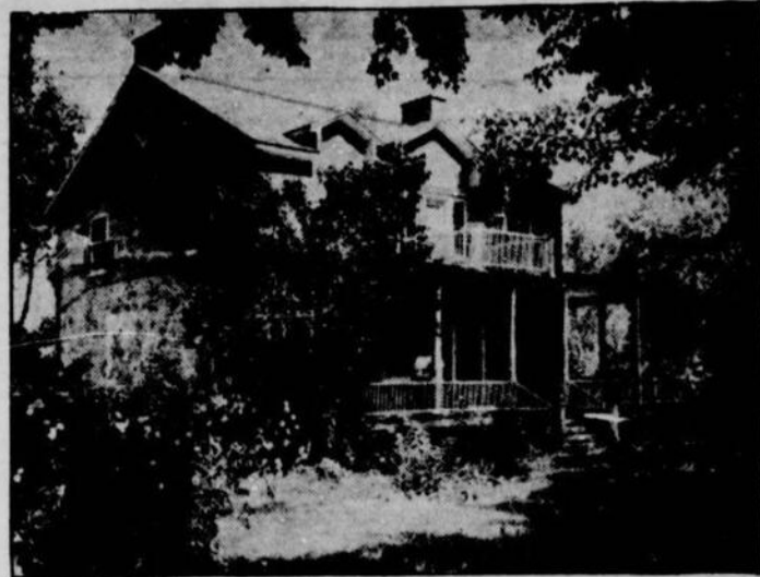
La maison de M. J.-S. LABELLE, 203, blvd Saint-Rose, à Saint-Rose, a été construite en 1756. Située en face de la rue Gagnon, elle fut restaurée en 1922. Cette année-là on enleva une section qui se trouvait du côté ouest de l'édifice. La photographie laisse voir l'endroit où la couverture de cette "allonge" était accolée à la maison. A remarquer les dates ciselées dans la pierre au-dessus de la porte du second étage. Photo la "Patrie".
