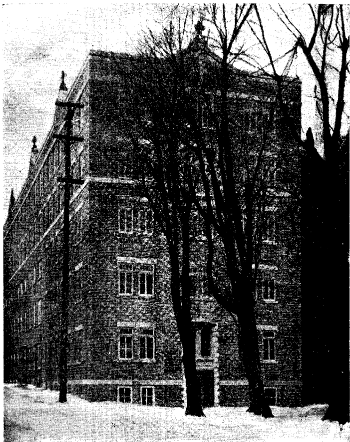
MAISON DES AUMONIERES ET DU GÉNÉRALAT construite sur l'emplacement de la première Maison Saint-Vincent de Paul qui dut être démolie en 1926
