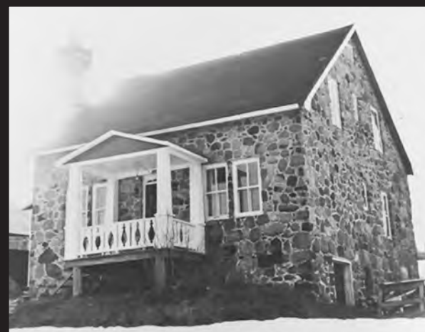
La maison de Napoléon Gascon, sur le 8 e Rang, que l'on voit au loin sur la photo précédente. En fait, il s'agit d'une maison à charpente de bois, lambrissée de pierres. Collection : Claudine Gascon.
