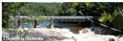
Chute de la cheminée
