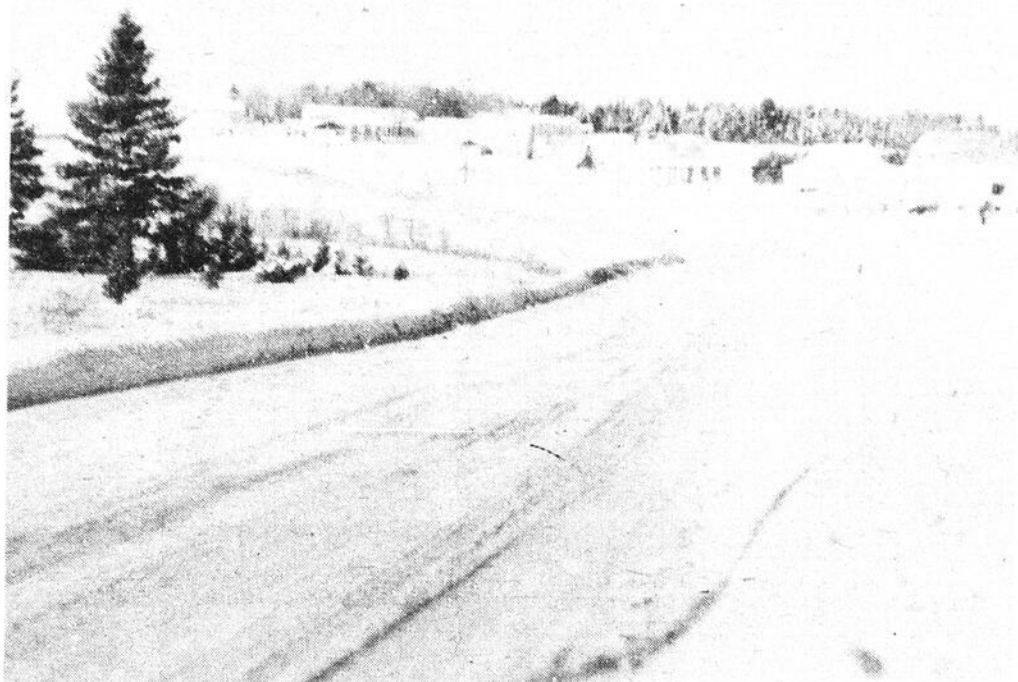
La route 347 est en bien piètre état, comme le démontre cette photo.
