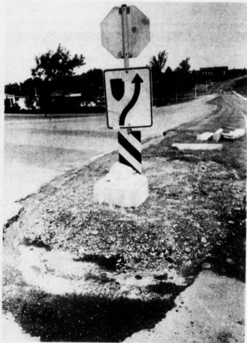
(Photo La Tribune par Stéphane Lemire) La pose de cette base de béton, à la hauteur des boulevards Portland et Lionel-Groulx, a nécessité de briser des aménagements fraîchement complétés.
