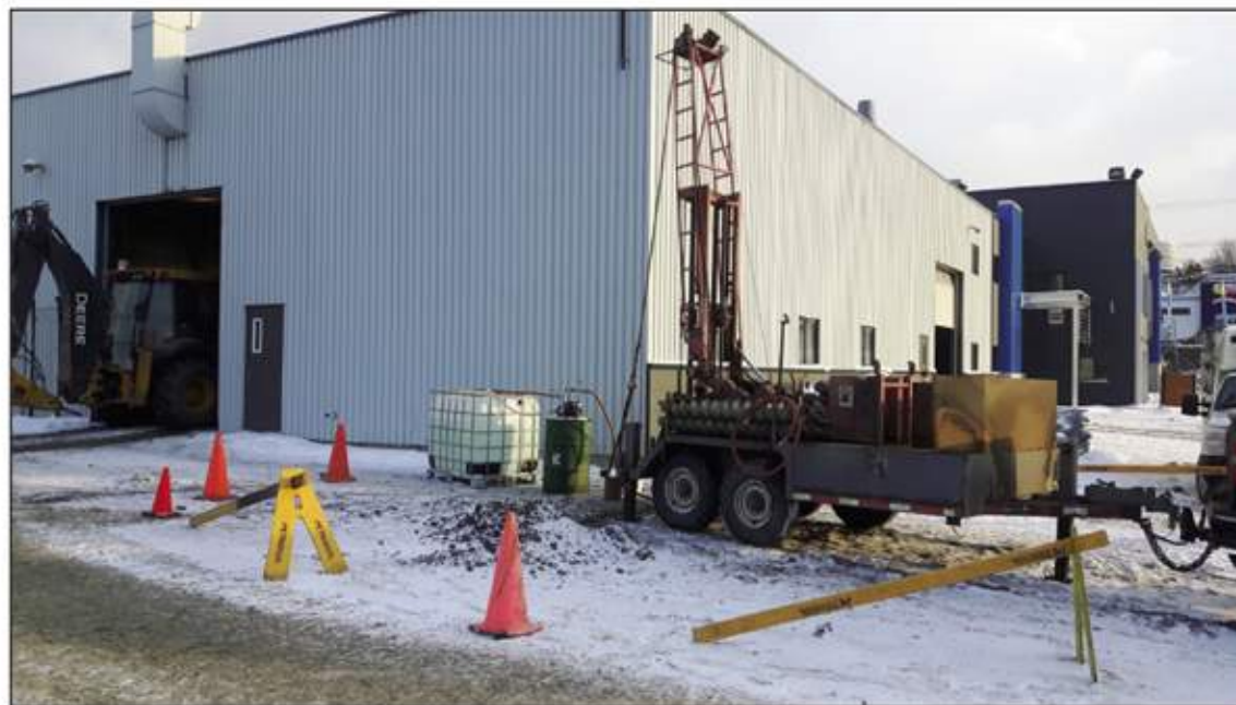
Décontamination des sols et de l'eau souterraine par traitement in situ
