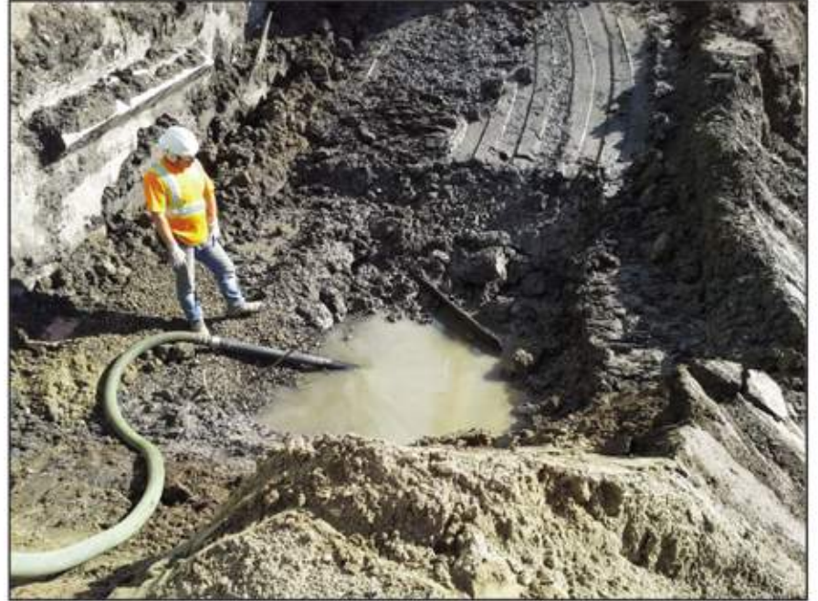
Pompage d'eau souterraine contaminée et traitement
