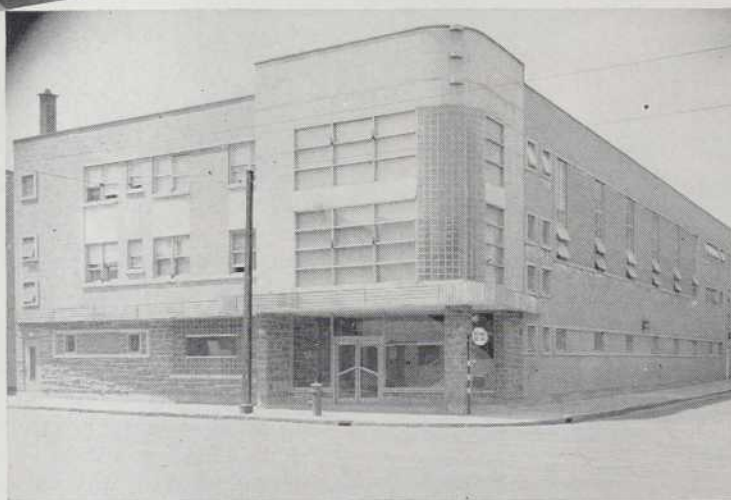
Architecte : J. Eugène Perron
