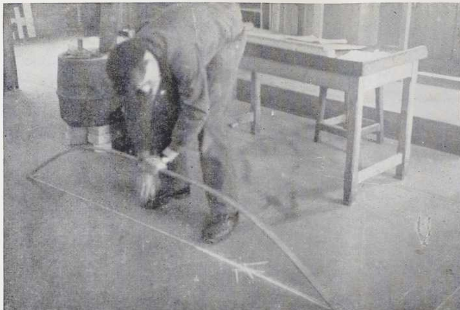
Atelier de charpente de l'école "Les Casernes", au Havre, France. Un apprenti fait un tracé à l'aide d'un arc et d'une ficelle enduite de craie.
