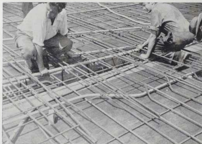
Futurs électriciens sur un projet réel, à Montréal.
