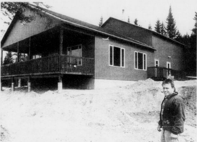
NOUVEAU LOGIS - Gaetan Bergeron n'est pas peu fier du nouveau logis que s'est offert Cascade Aventure, au cours de l'hiver. Un investissement de 150 000 $ qui procurera sans doute beaucoup de confort aux amateurs de rafting, une fois bien au sec...
