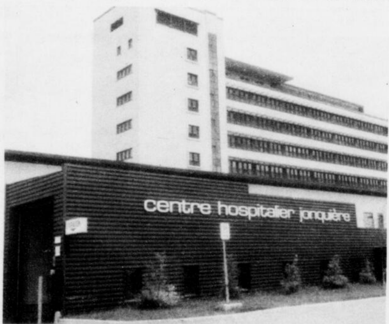
RISQUE - Faire du Centre hospitalier de Jonquière un centre de services ambulatoires comporte tout un risque, celui de tout perdre, selon le Dr Louis-René Barrette.
