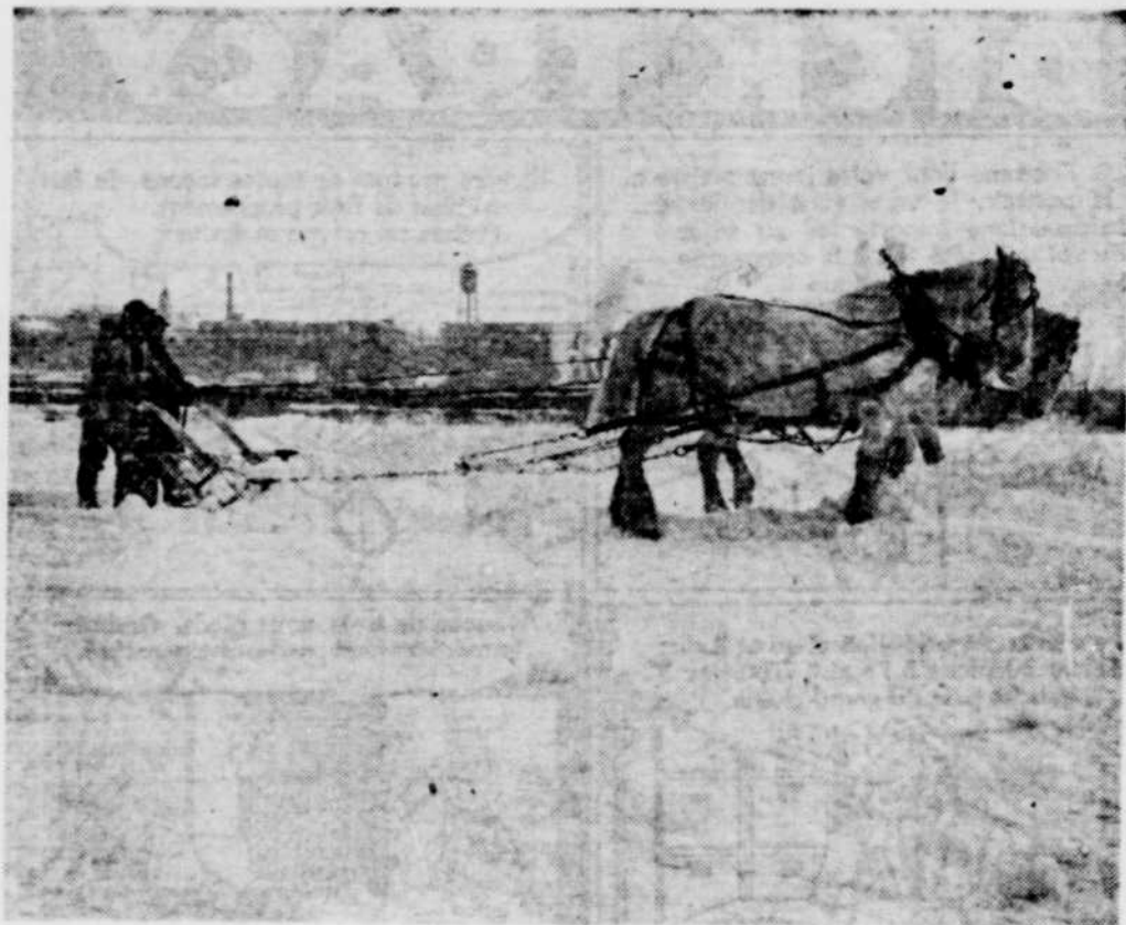
Premier acte de l'opération — Deux hommes retiennent une charrue tirée par deux chevaux. Dans quelque temps, tout l'espace nécessaire sera déblayé. Une fois la couche de neige partie, commencera l'opération du sciage mécanique et manuel. Le champ est libre ! (Photo La Tribune)
