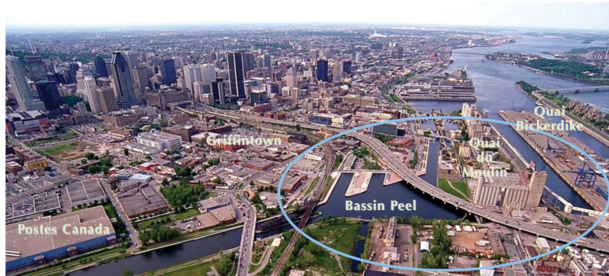
Figure 6.40 Le secteur des bassins aux abords de l’autoroute Bonaventure.
