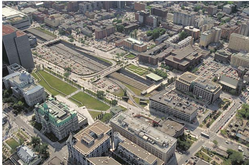
Figure 6.42 La tranchée de l'autoroute Ville-Marie au nord du Champ-de-Mars. Un potentiel de développement de plus de 185 800 m 2 .
