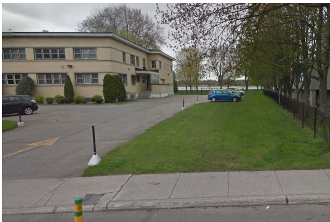
Figure 4-6 : Emplacement de l'accès n° 3 situé sur le terrain des Frères de Saint-Gabriel – Secteur de la résidence Berthiaume-Du Tremblay
