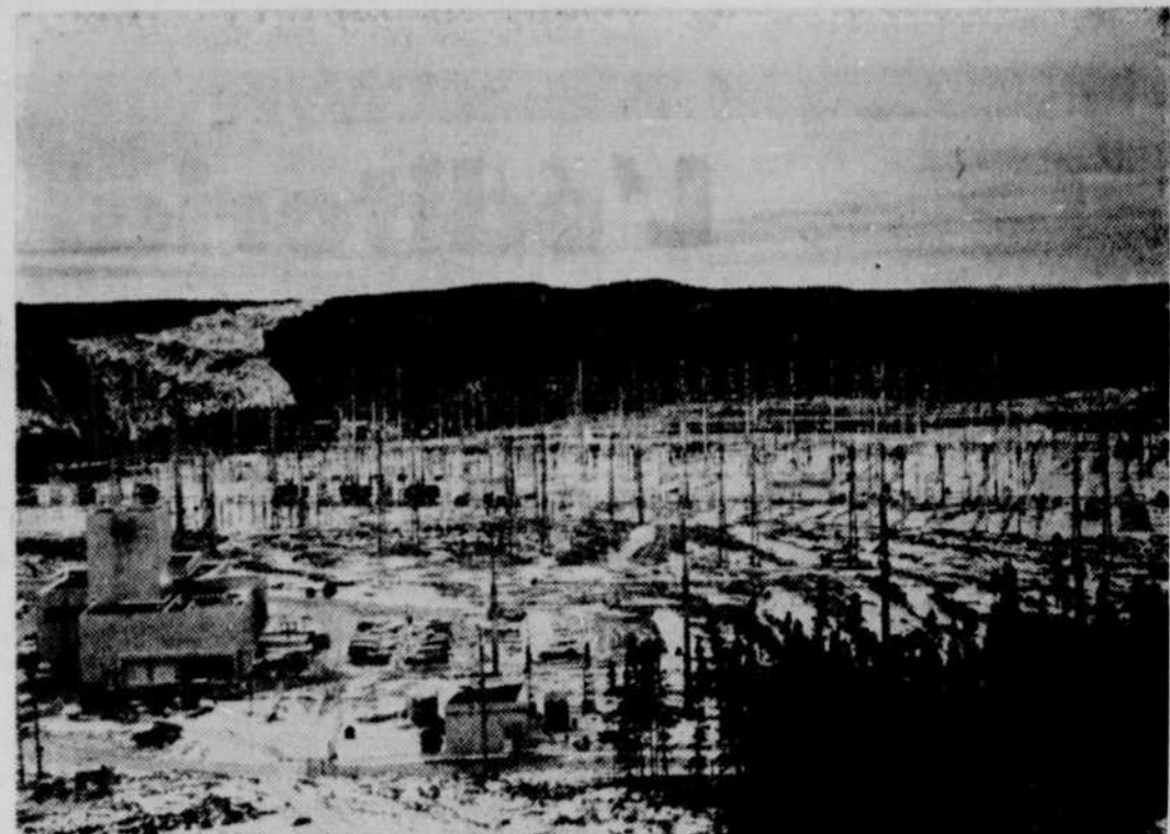
C'EST EN SURFACE, dans le poste de manoeuvre de Churchill Falls, que la tension de l'énergie est portée à 735,000 volts pour son transport et son intégration au réseau de l'Hydro-Québec. Une première transformation, de 15,000 à 230,000 volts, est effectuée par des transformateurs voisins de la salle des machines de la centrale souterraine. Effectués récemment, les essais de mise en service des deux premiers groupes de Churchill Falls ont pleinement réussi.
