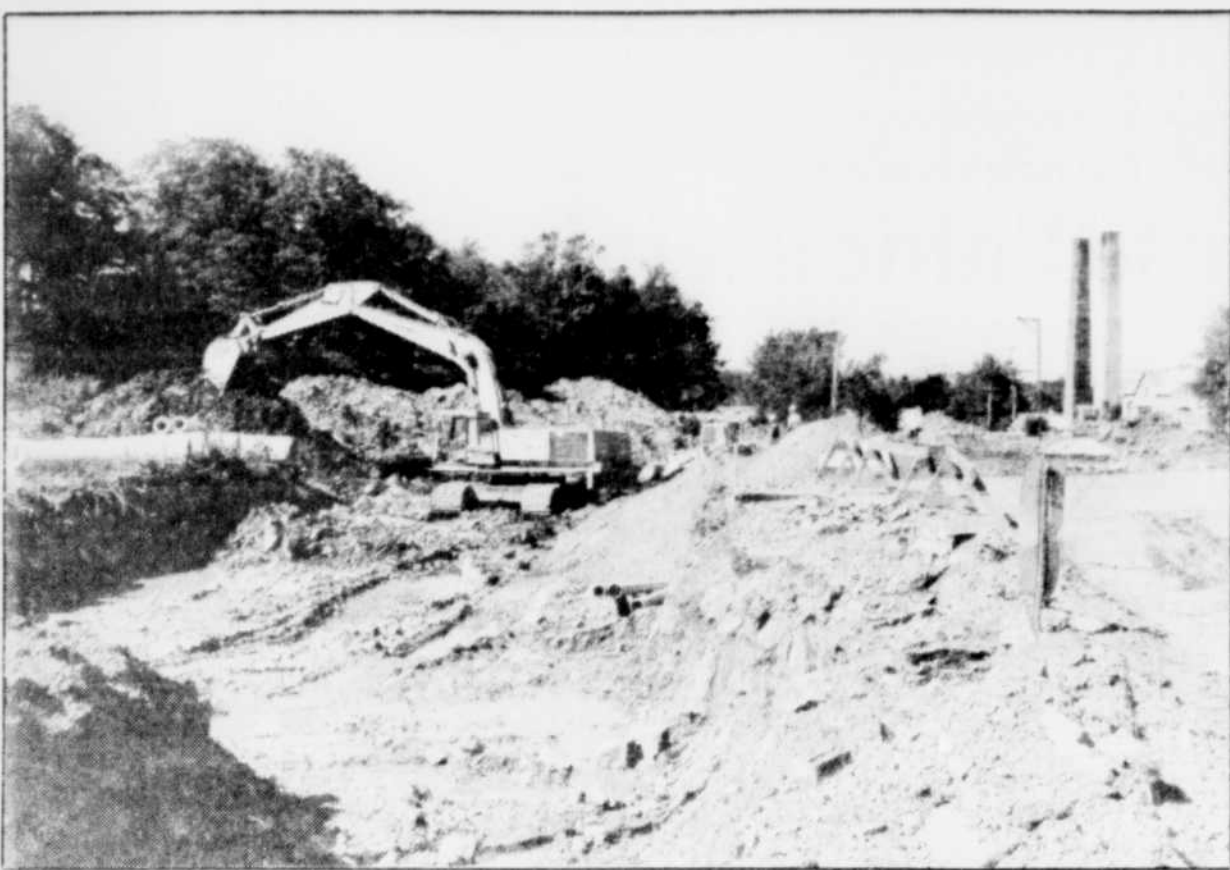
Le redressement de la rue Saint-Laurent et l'implantation des services d'eau et d'égouts doivent être terminés vers la mi-septembre, dans ce secteur de Lévis-Lauzon situé près de l'industrie Baribeau.
