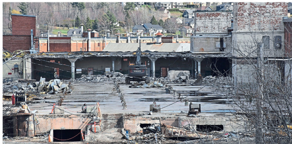
Environ trois mois de travaux ont été nécessaires pour compléter ce grand ménage.
