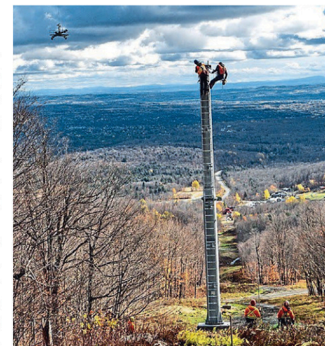
Les travaux d'installation du nouveau télésiège donnent lieu à quelques scènes spectaculaires, notamment le transport des pièces via les airs et l'installation en hauteur. (Photo gracieuseté - Marco Bergeron)
