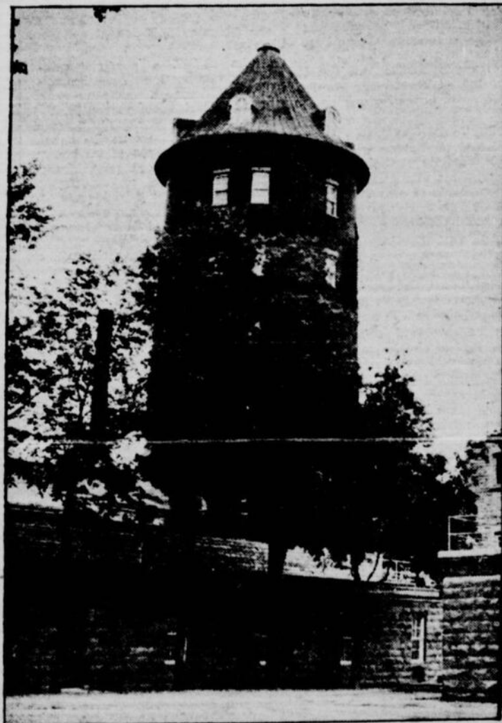
Une des plus vieilles tours de l'hôpital Saint-Jean-de-Dieu, datant de plus de 60 ans, fut menacée de destruction, hier après-midi, au cours de la tempête qui balaya la région. Elle fut frappée par la foudre. Les pompiers réussirent toutefois à la sauver. Seule la pointe de la tour fut détruite. (Photo la "Patrie").
