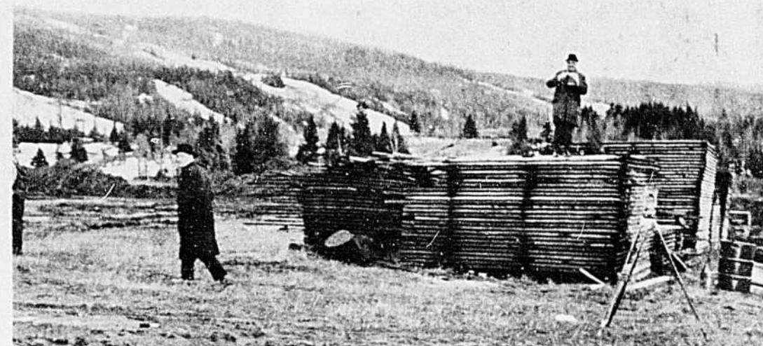
Même M. Guy Poliquin, président des Autoroutes se sert de sa caméra pour prendre des photos. Ici, on le voit face à St-Sauveur et ses côtes 68-69-70 le coup d'oeil en vaut la peine. A droite, on remarque M. Roger Trudeau ingénieur en chef.
