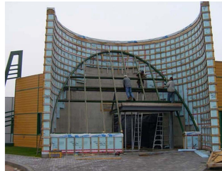
Nouveau CMC de Wemindji en cours de construction, juin 2015
