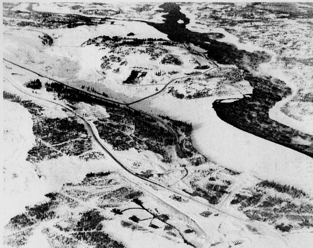
LG-3 — Vue aérienne de l'emplacement des principaux travaux de LG-3. Le barrage s'appuiera sur l'île, au milieu de La Grande Rivière, en aval du portail des galeries de
