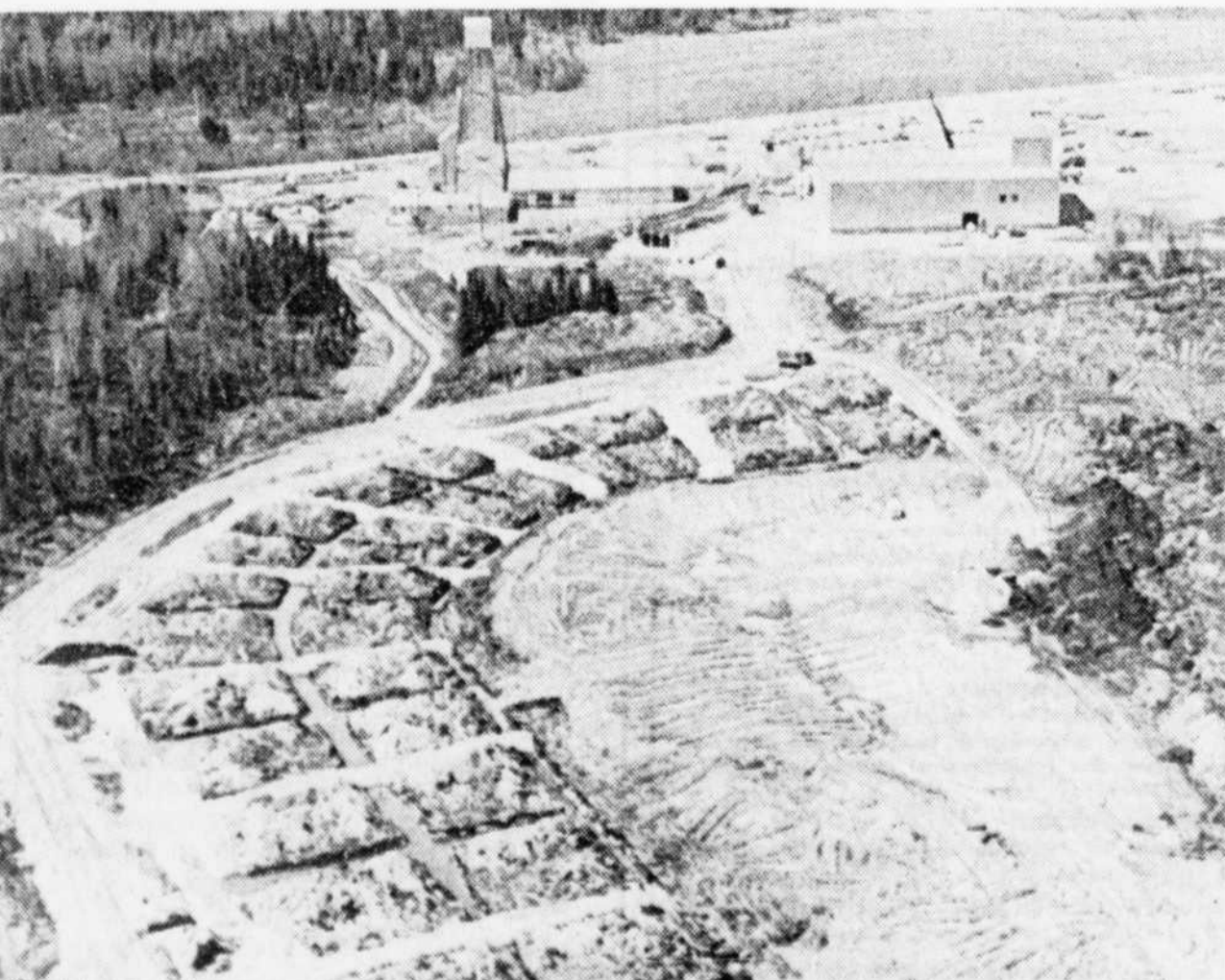
Le chantier de Niobec à St-Honoré à une dizaine de milles au nord de Chicoutimi.
