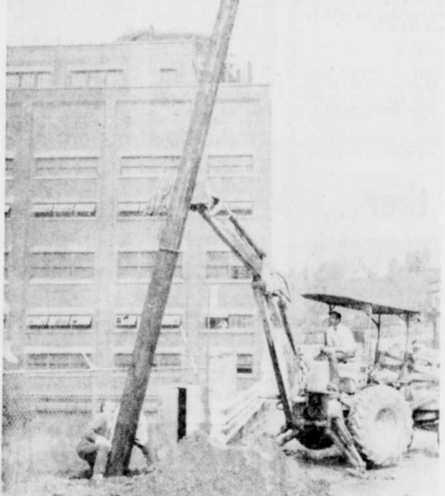
Les premiers poteaux d'éclairage ont été installés hier aux courbes du moulin. A cause des améliorations apportées à la route, plus précisément à cause de l'élargissement de la route, il faut changer l'emplacement des poteaux actuels. Il faudra répéter cette opération une dizaine de fois.
