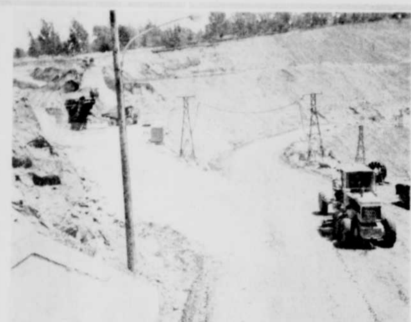
Hier une route, aujourd'hui un trou. — La compagnie Canadian Johns-Manville a commencé l'enlèvement du mort-terrain (partie supérieure de la photo) à l'endroit où prenait place, il y a à peine un mois, la principale voie d'accès à la ville d'Asbestos.
