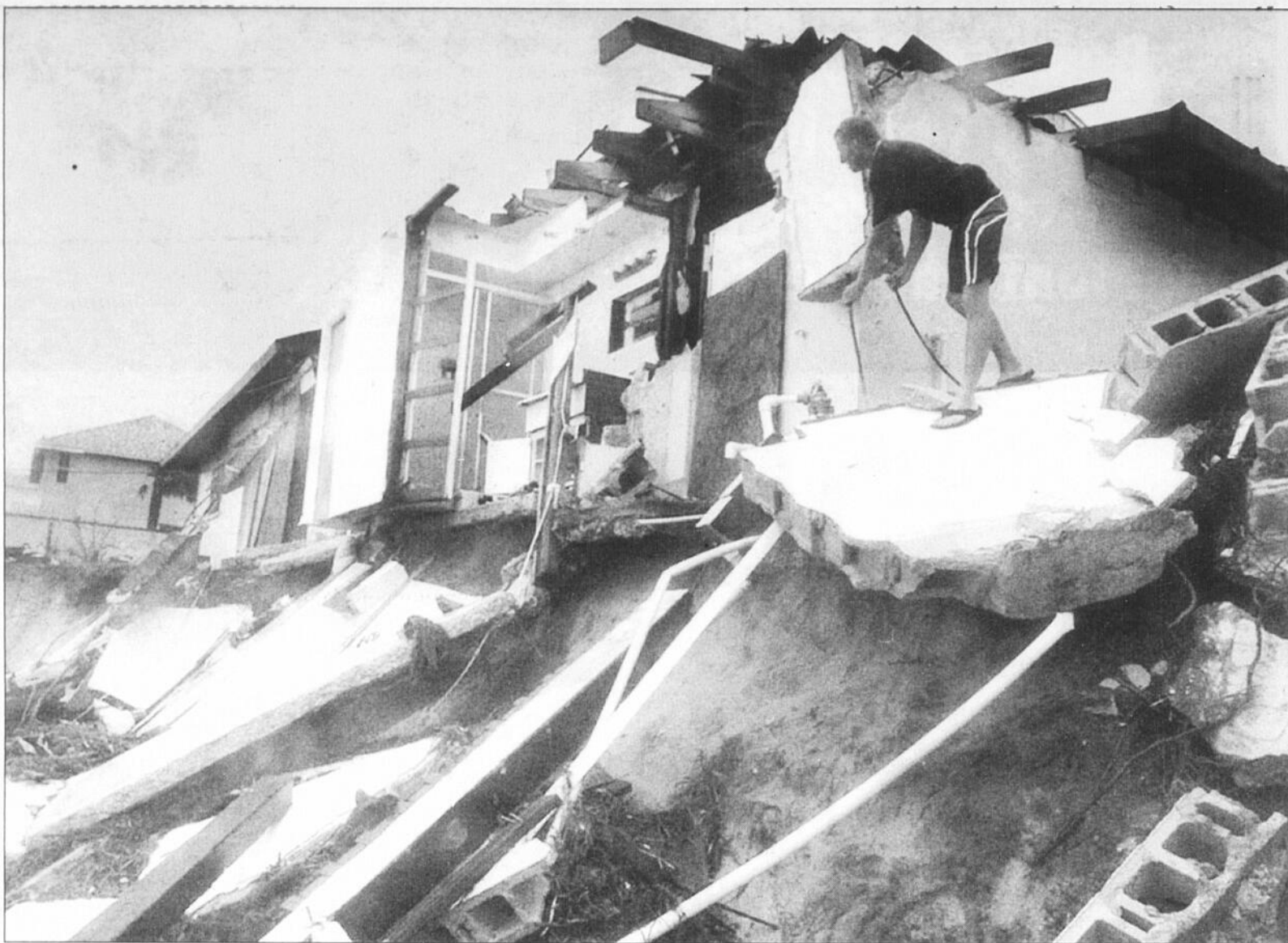
DÉGÂTS - Avec des rafales de vent atteignant les 177km/h, l'ouragan a arraché de nombreuses toitures alors que les pluies diluviennes ont provoqué des glissements de terrain comme ici sur la rue Shell à Satellite Beach dans le nord de la Floride.
