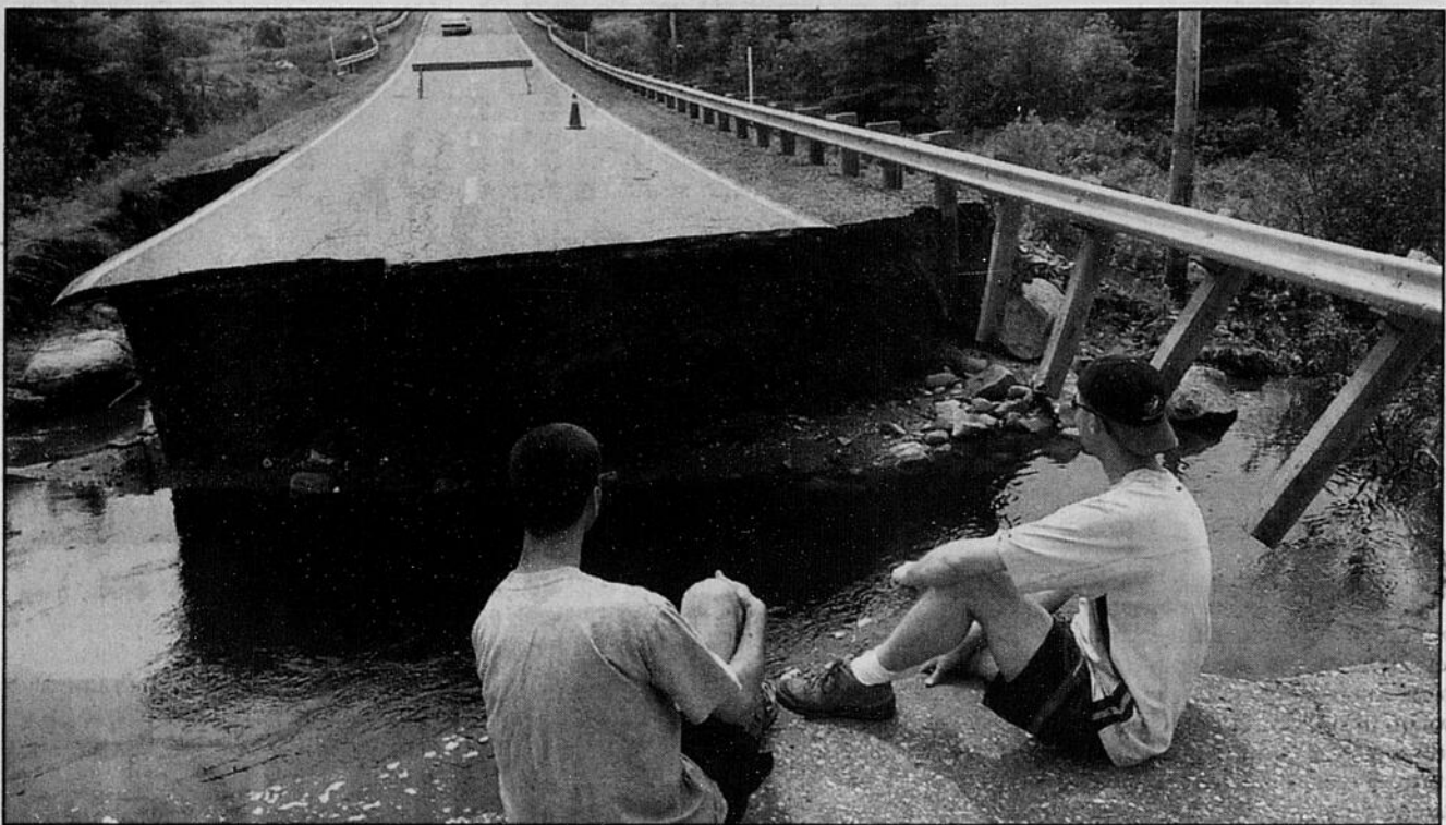
La Tribune, archives Dans la nuit du 30 juin au 1er juillet 2002, des orages violents ont causé de nombreux dommages dans le secteur de Lac-Mégantic. Les eaux ont emporté une section du rang 9 de Sainte-Cécile-de-Whitton.
