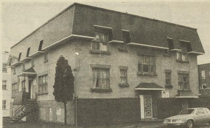
Cet immeuble, situé à l'angle des rues St-Paul et Notre-Dame, à St-Césaire, pourrait devenir un centre d'hébergement. Photo Alain Dion
