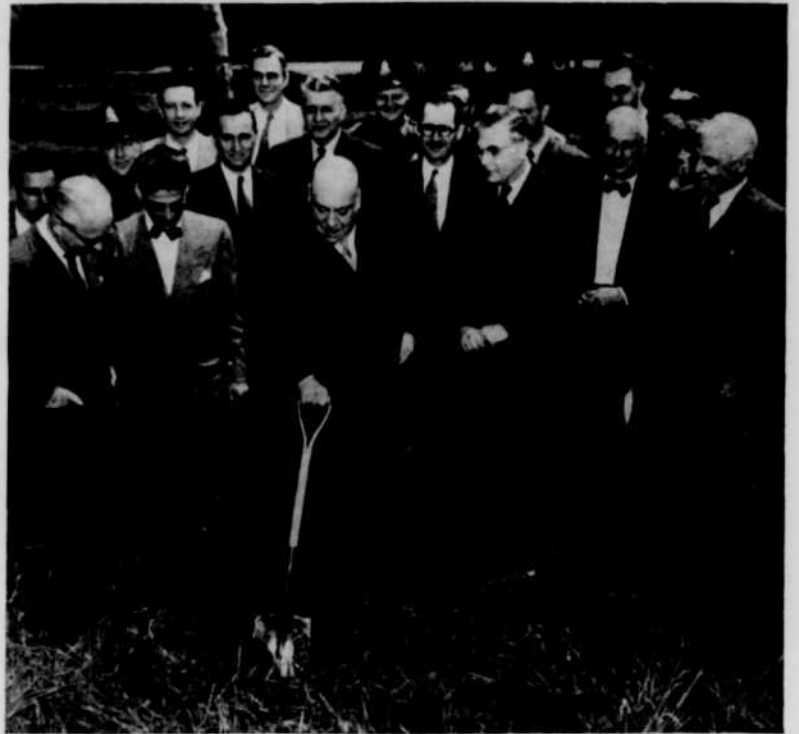
Le mercredi 13 juin, à 1 heure de l'après-midi au sommet du Mont-Royal, une brève cérémonie à laquelle assistaient le maire de Montréal, M. Camillien Houde et un groupe de hauts fonctionnaires de Radio-Canada, a marqué le commencement des travaux de construction du pavillon qui abritera le poste transmetteur de télévision. On reconnaît dans la photo, prise à cette occasion: (de gauche à droite) M. Donald Manson, directeur général adjoint de la Société Radio-Canada; P.-G. Léger, directeur adjoint du service des architectes; le Maire de Montréal, levant la première pelletée de terre; M. Augustin Frigon, directeur général de Radio-Canada; M. Aimé Cousineau, directeur du service d'urbanisme de la ville de Montréal; M. René Morin, vice-président du Bureau des Gouverneurs de Radio-Canada. On remarque, à l'arrière, des hauts fonctionnaires de Radio-Canada, notamment: M. Henri Audet, ingénieur de la région de Montréal; M. J.-A. Ouimet, ingénieur en chef et coordonnateur de la télévision; M. Charles Frenette, directeur des services techniques de la télévision; Marcel Carter, adjoint à l'Exécutif de Radio-Canada ainsi que M. Raymond Matte, entrepreneur.
