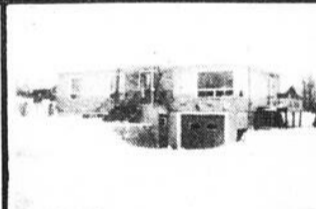
CACOUNA: 290 rue du Parc-Bungalow 28 x 44, garage-sortie de sous-sol extérieur.
