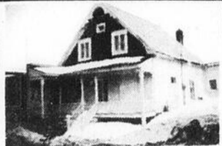
RIVIERE-DU-LOUP: 5, 7 rue St-Elzéar, 2 logements.
