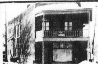
RIVIERE-DU-LOUP: 98 rue Fraserville-3 logements-bas prix.
