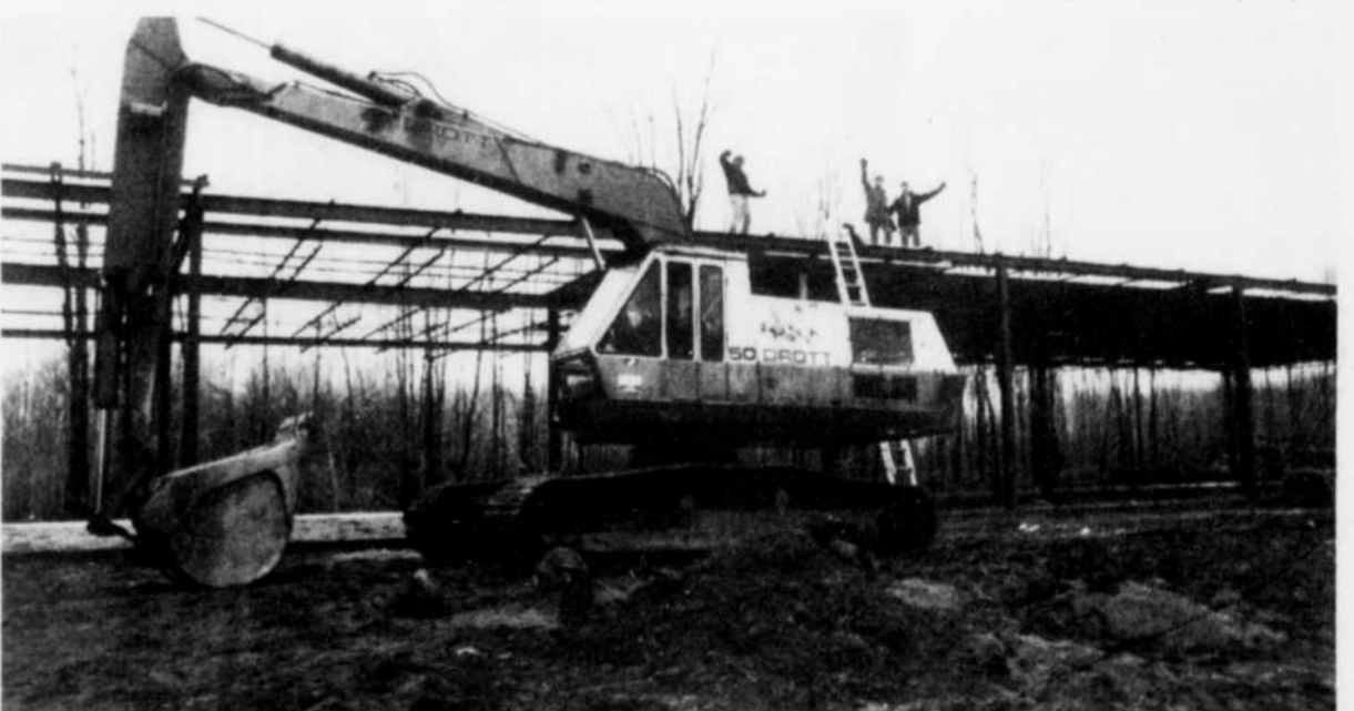
La charpente de l'usine Jean Goubin de France se dresse angle Labonté et Gauthier dans le parc industriel régional. Cette entreprise agro-alimentaire transformera la viande des pintades, qui sont présentement élevées à Lefebvre.
