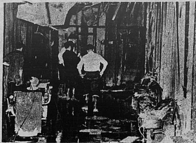
Le salon de barbier Ronda est une perte totale et une quinzaine d'établissements commerciaux avoisinants ont été plus ou moins endommagés.
