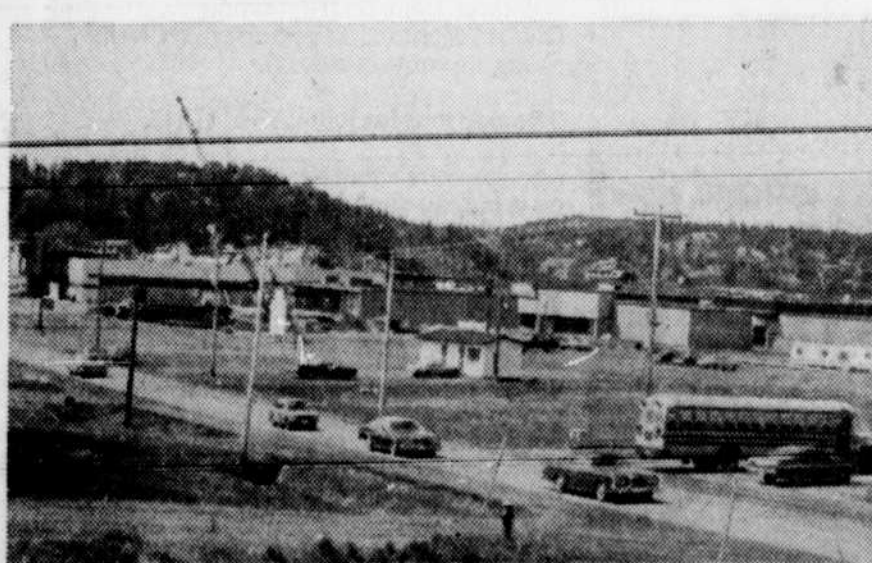
L'un des deux projets de centres commerciaux de La Pocatière, celui des "Galeries La Pocatière Inc." est présentement en construction, à un mille et demi à l'ouest du centre-ville. Il regroupera 33 magasins et boutiques.
