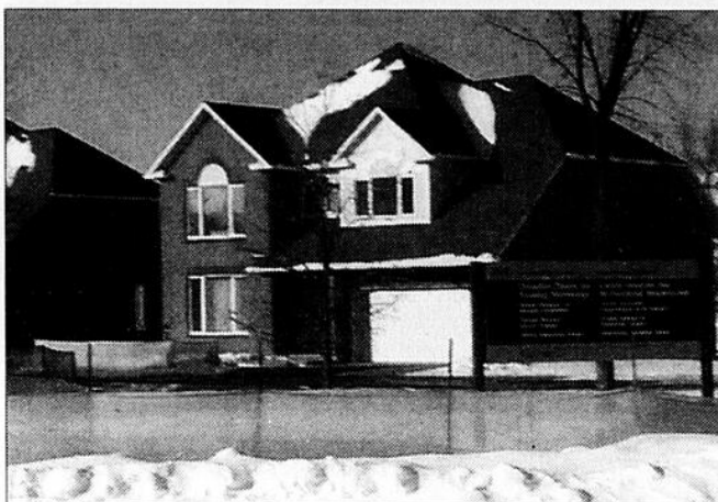
Le Centre des technologies résidentielles est composé de trois résidences qui répondent à des normes d'isolation et de ventilation.
