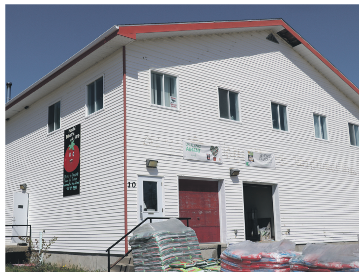
La Bioferme du Nord est propriétaire de l'ancien bâtiment de Coquillages Nordiques sur la route Maritime à Forestville. Photo Renaud Cyr
