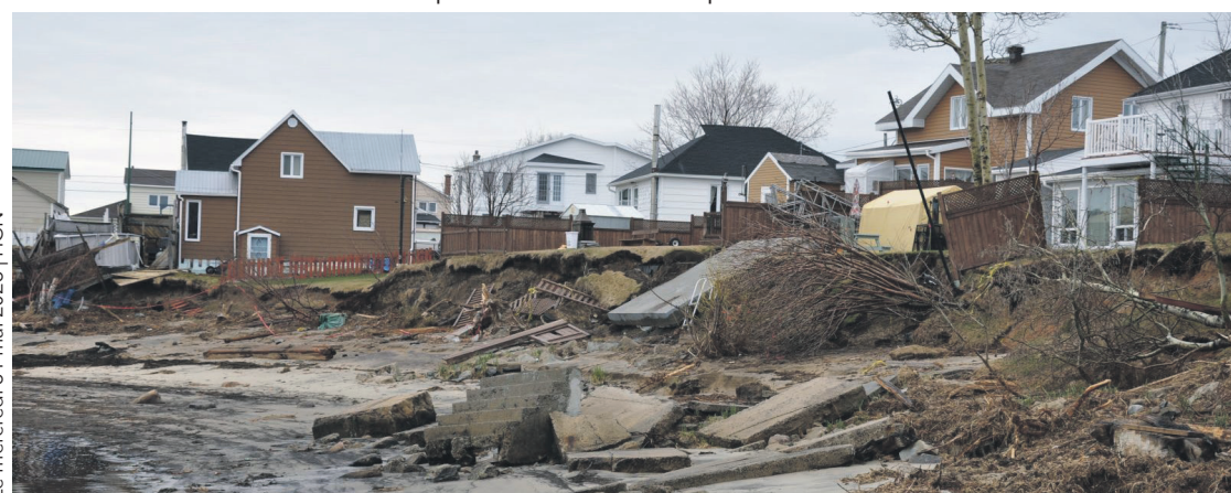
18 | Le mercredi 31 mai 2023 | HCN Une image frappante d'érosion des terrains de la plage McCormick en 2019. Photo archives
