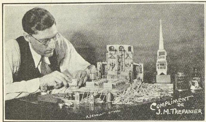
FIG. 3.—Les travaux à deux mois.
